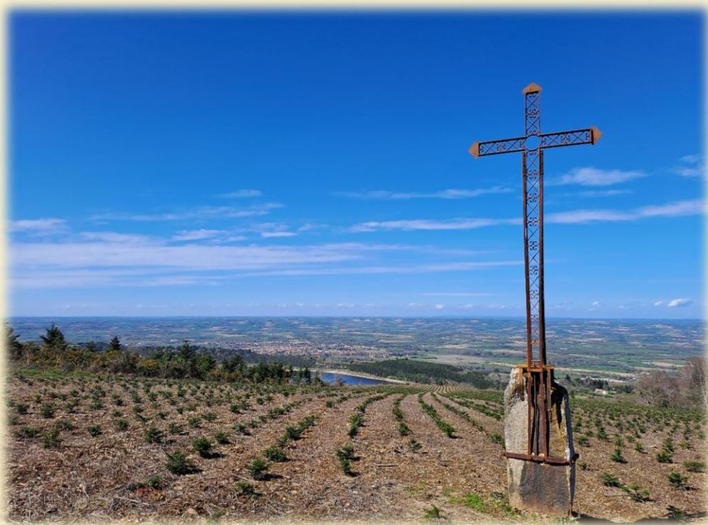
ressemble à un menhir, elle doit être enfouie très profondément dans le sol. Les boulons du support ont été forgés et filetés à la main. Les quatre haubans assurent la rigidité entre la croix et le socle et aident à la solidité de l'ensemble. L'ouvrage porte une plaque gravée avec le nom : AUGÉ. 1909. Comme le souhaitait son propriétaire, elle est orientée face au village de Puylaurens.
